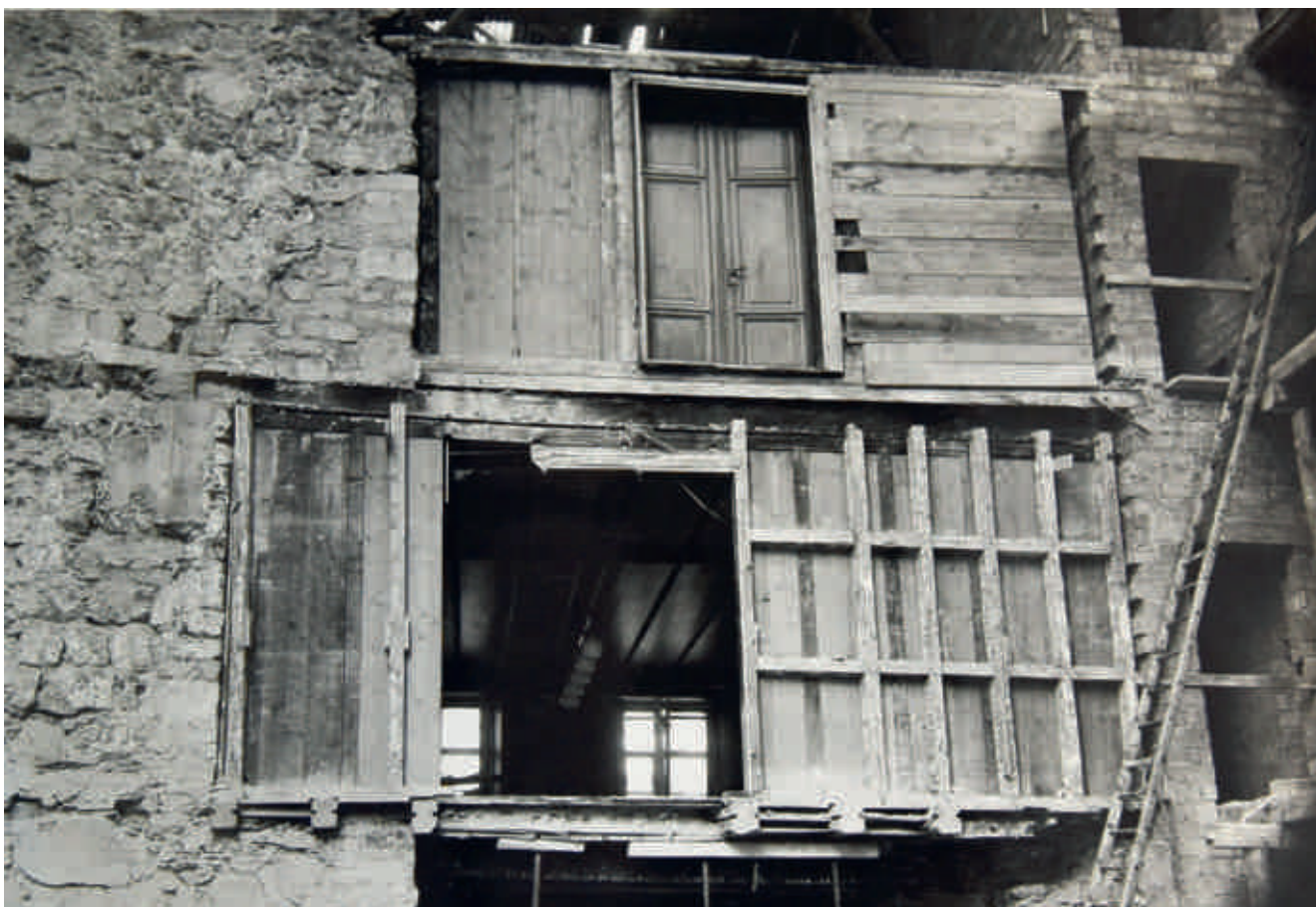
9: Blick von Süden an die beiden Ratsäle im ausgehöhlten Treppenhaus des Rathauses, um 1955. Stadtarchiv Aarau, Fotodokumentation Rathausumbau 1954-57.
