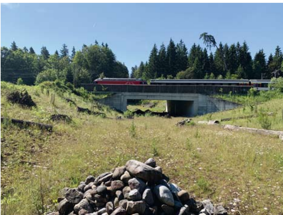
Im Suret-Wald führt eine Eisenbahnlinie mitten durch den Wald. Die SBB gestaltete die ehemalige Wegunterführung für Spaziergänger als Wildunterführung um.
