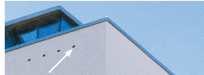
Fertiggestellter Neubau mit eingebauten Seglernistplätzen.
