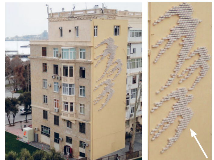
Neues Nistplatzangebot für die Mauersegler aus dem sanierten alten Turm von Baku (Bild: Atelier Erich Pummer GmbH).
