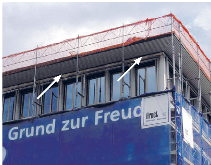
Baugerüst, durchlässig für die Alpensegler. Die Arbeiten an der Dachuntersicht wurden rechtzeitig beendet.
