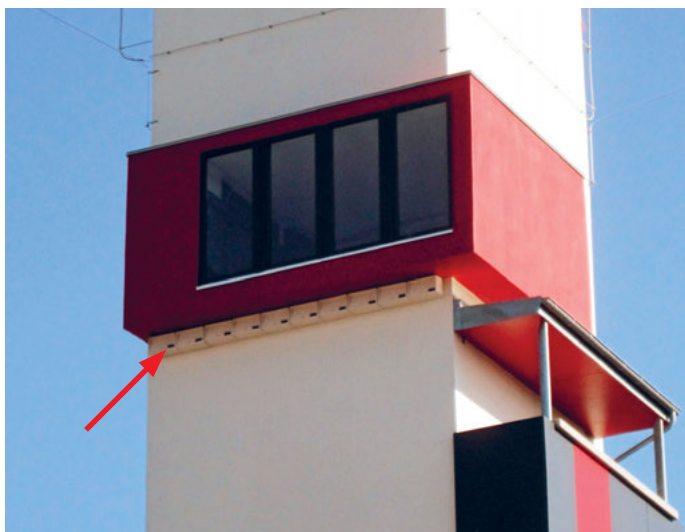
Originelle Idee: Mauerseglernistkästen am Schlauch- und Übungsturm der Feuerwehr der Stadt Offenbach am Main (Bild: Stadt Offenbach a. Main).
