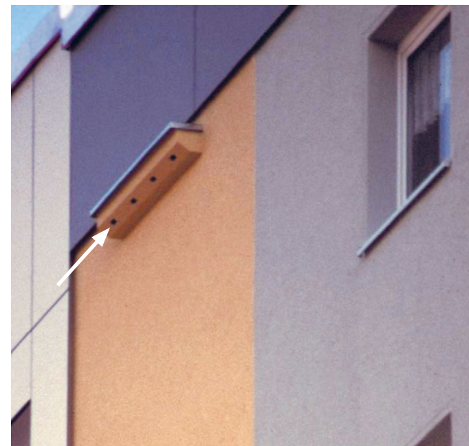
Dem Gebäude angepasster Nistkasten für Mauersegler bei einem Neubau. (Bild: J. Börner, Chemnitz)
