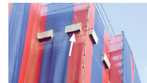
Alpenseglernistkästen an einem Baugerüst.
