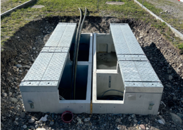
Sanierung der Infrastruktur-Fundamente der neuen Verteilkabine.
