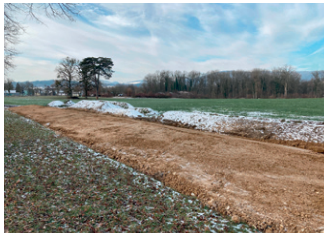
Erstellung des Hochwasserschutzdamms.
