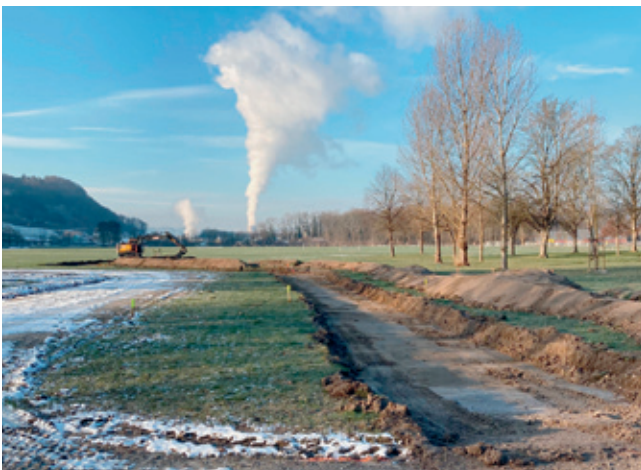
Arbeiten zur Infrastrukturerneuerung des Schaustellerplatzes Schachen.
