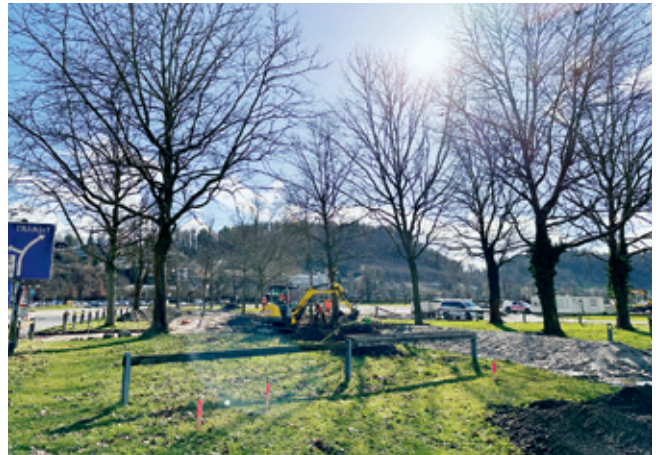
Arbeiten am Hochwasserschutz im Schachen.
