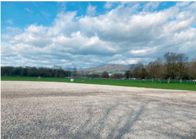
Sanierung der Infrastruktur auf dem Schaustellerplatz im Schachen.
