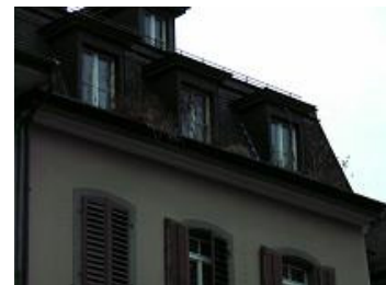
Nistkästen und Zutritte für Mauersegler fehlen.
