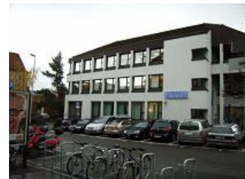
Versiegelte Fläche, Parkplätze
