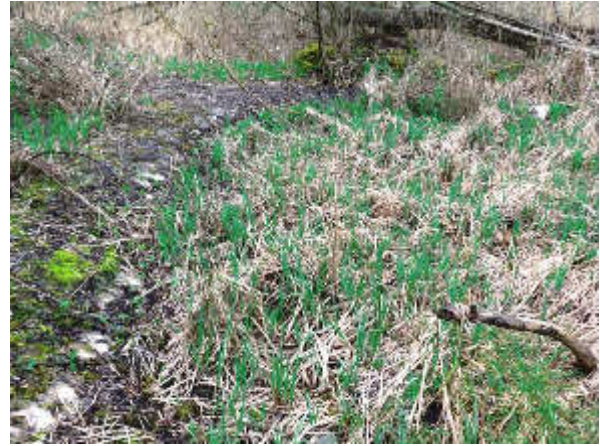
Abb. 2. Links im Bild vermooster Betonrand.
