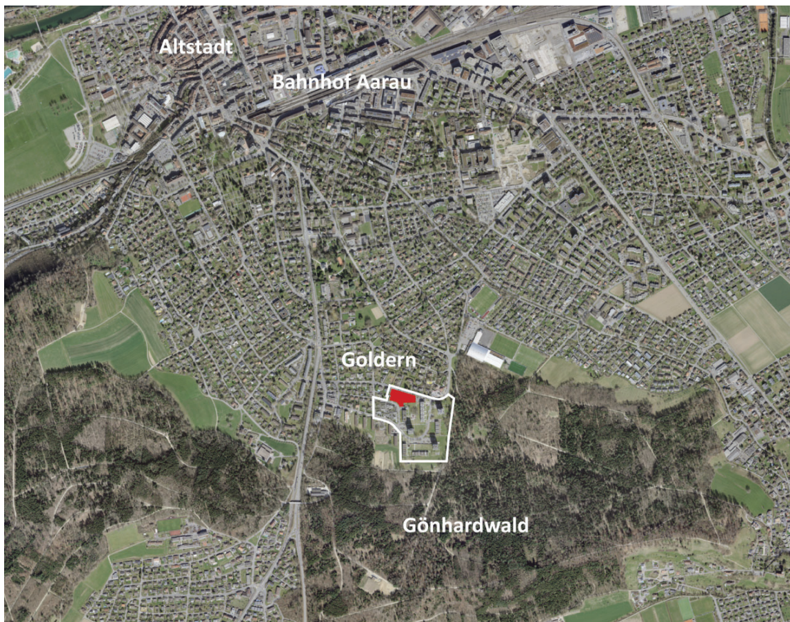
Abb. 1 - Situation Goldern (Überbauung Goldern = weiss ausgezogene Linie; Parzellen im Eigentum UBS = rote Fläche); Quelle: AGIS, 2021
