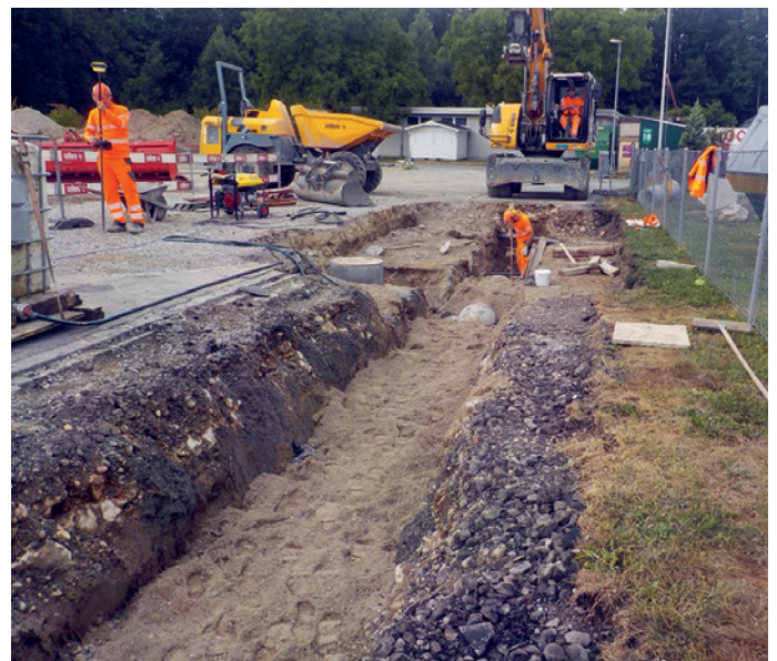
Leitungsarbeiten an der Schwimmbadstrasse. Foto: Berger Wenger Plattner AG
