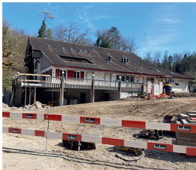
Aussenansicht Baustelle Restaurant Roggenhausen. Foto: Anja Stahel
