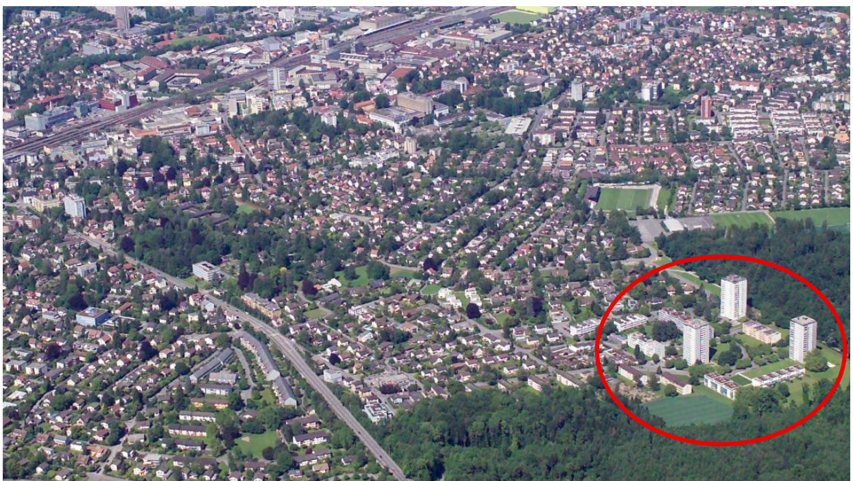
Abbildung 1: Lage der Überbauung Goldern am südlichen Siedlungsrand der Stadt Aarau (Quelle: ETH-Bibliothek Zürich, Bildarchiv / AIC_02-0Y-242290-001)
