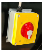
INTERRUTTORE DI SERVIZIO / HT SERVICE SWITCH
