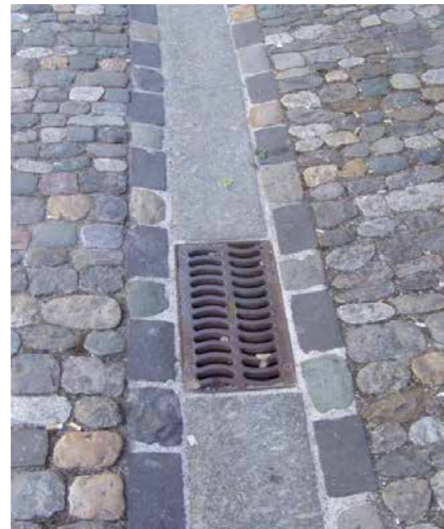
Entwässerungsrinne mit Gneisplatten und eckigen Pflastersteinen eingefasst
