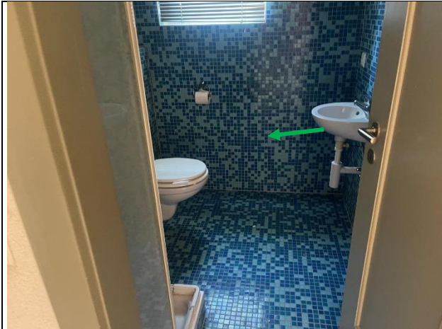
ID-28: Fliesenkleber Wand und Boden Standort: EG / Bad Bemerkung: kein Asbest festgestellt
