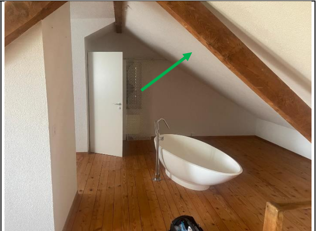
ID-8: Verputz Decke Standort: OG / Bad Bemerkung: kein Asbest festgestellt
