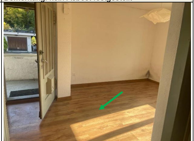
ID-18: Holzparkett Standort: EG / Zimmer und Eingang Bemerkung: kein Schadstoffverdacht
