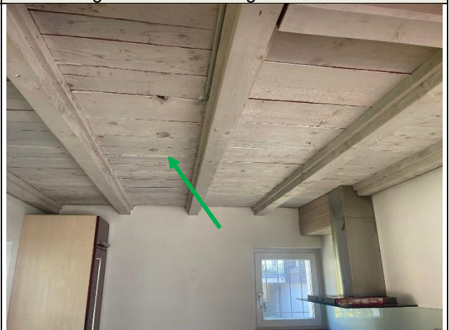
ID-10: Holzdecke Standort: EG / Küche Bemerkung: kein Schadstoffverdacht
