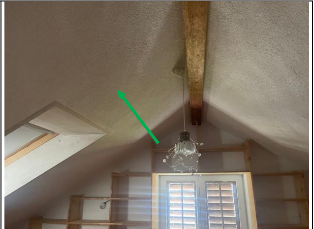
ID-2: Verputz Decke Standort: OG / Zimmer Bemerkung: kein Asbest festgestellt
