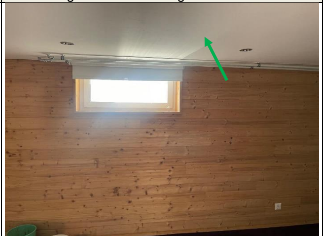
ID-22: Holzdecke Standort: UG / Zimmer Bemerkung: kein Schadstoffverdacht
