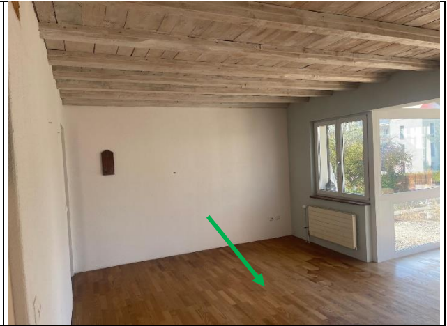
ID-14: Holzparkett Standort: EG / Zimmer Bemerkung: kein Schadstoffverdacht
