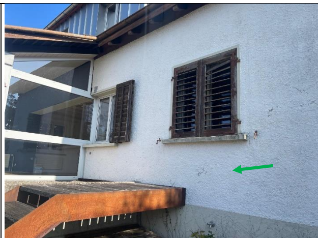
ID-30: Verputz Standort: Aussen / Fassade Bemerkung: kein Asbest festgestellt
