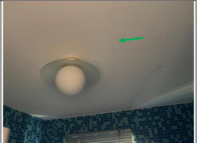
ID-29: Verputzt Decke Standort: EG / Bad Bemerkung: kein Asbest festgestellt
