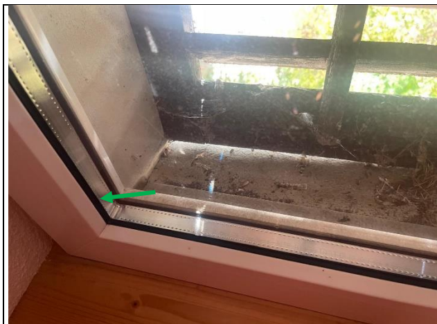
ID-19: Fenster neu mit Silikon Standort: Aussen / Fassade Bemerkung: kein Schadstoffverdacht
