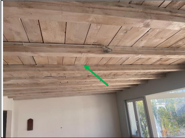
ID-13: Holzdecke Standort: EG / Zimmer Bemerkung: kein Schadstoffverdacht
