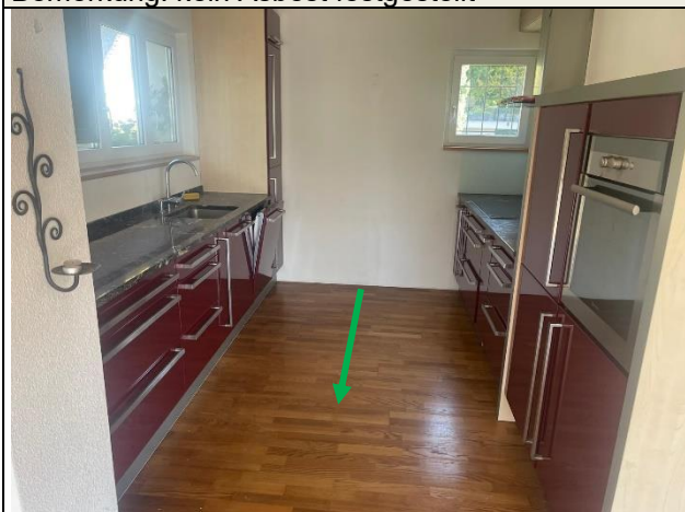
ID-11: Holzparkett Standort: EG / Küche Bemerkung: kein Schadstoffverdacht
