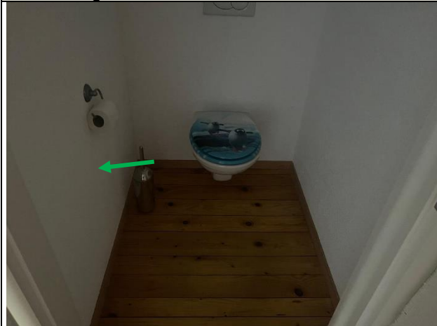
ID-5: Verputz Wand Standort: OG / WC Bemerkung: kein Asbest festgestellt
