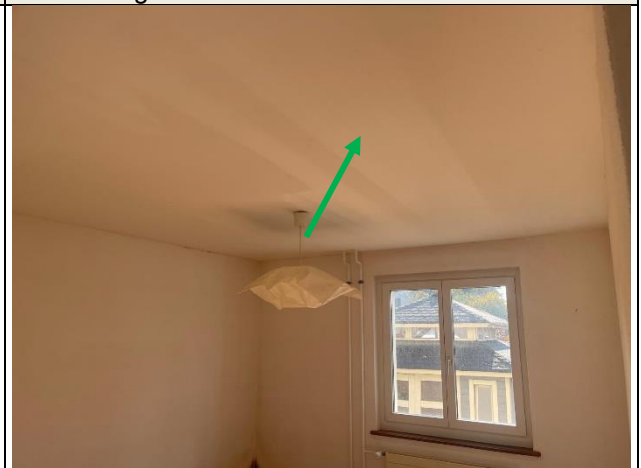
ID-16: Verputzt Decke Standort: EG / Zimmer und Eingang Bemerkung: kein Asbest festgestellt
