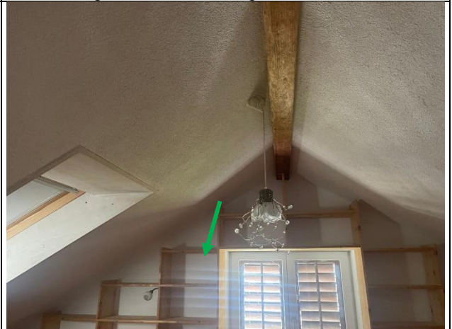
ID-4: Verputz Wand Standort: OG / Zimmer Bemerkung: kein Asbest festgestellt
