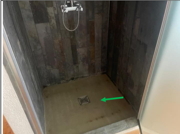
ID-7: Betonboden Standort: OG / Bad Bemerkung: kein Schadstoffverdacht
