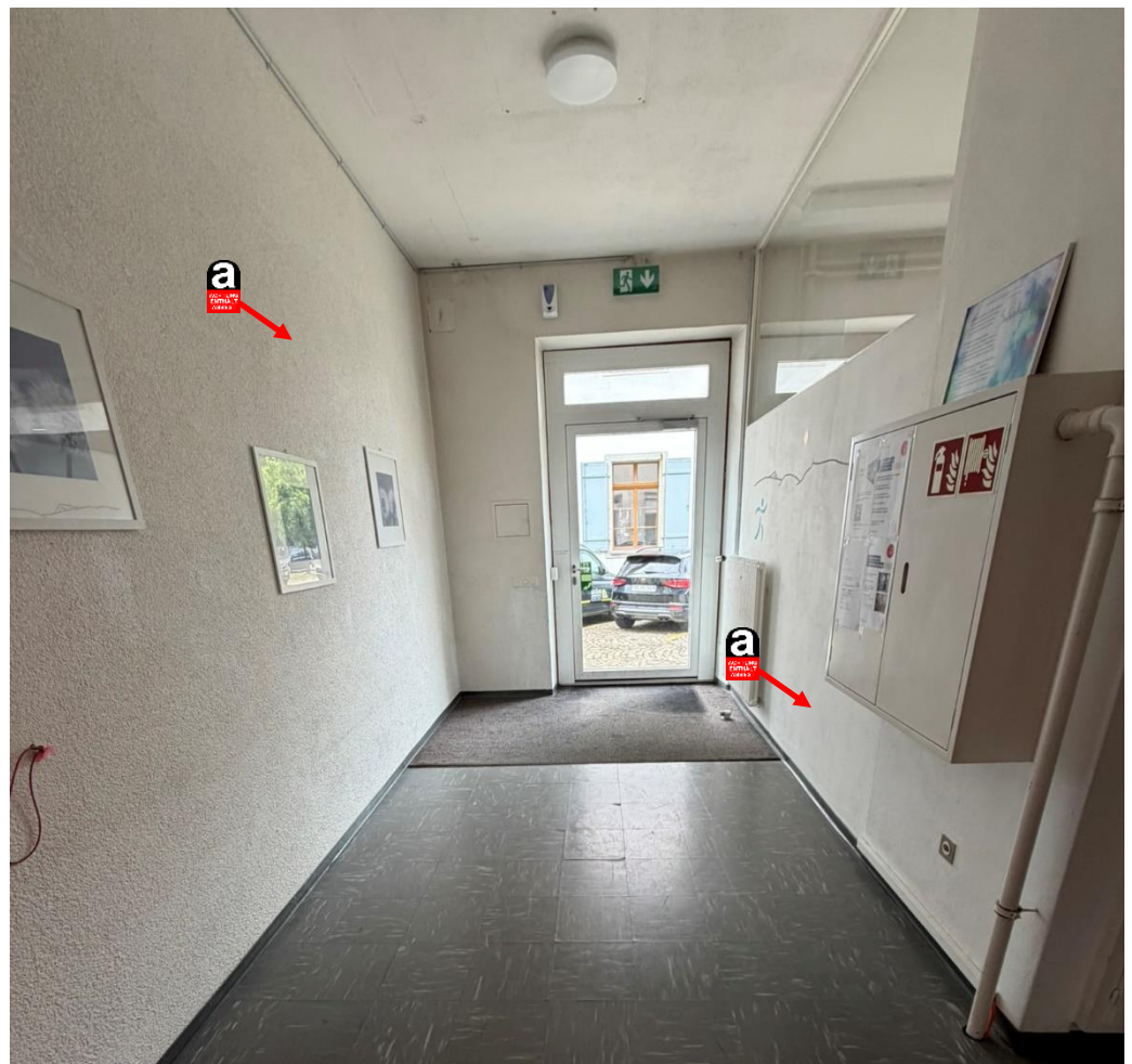
Abb. 10: Asbesthaltiger Putz
