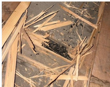
Abb. 2: Im Boden vom Estrich in Hausnr. 87 fand sich Schlacke.
