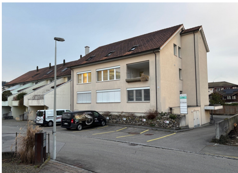
Abbildung 5: Liegenschaft am Sonnmatweg 6 vor dem Umbau
