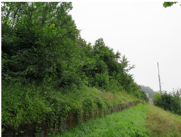
Abb. 2. Kleiner Zugangsweg zu den Installationen mit verbrachten Säumen.
