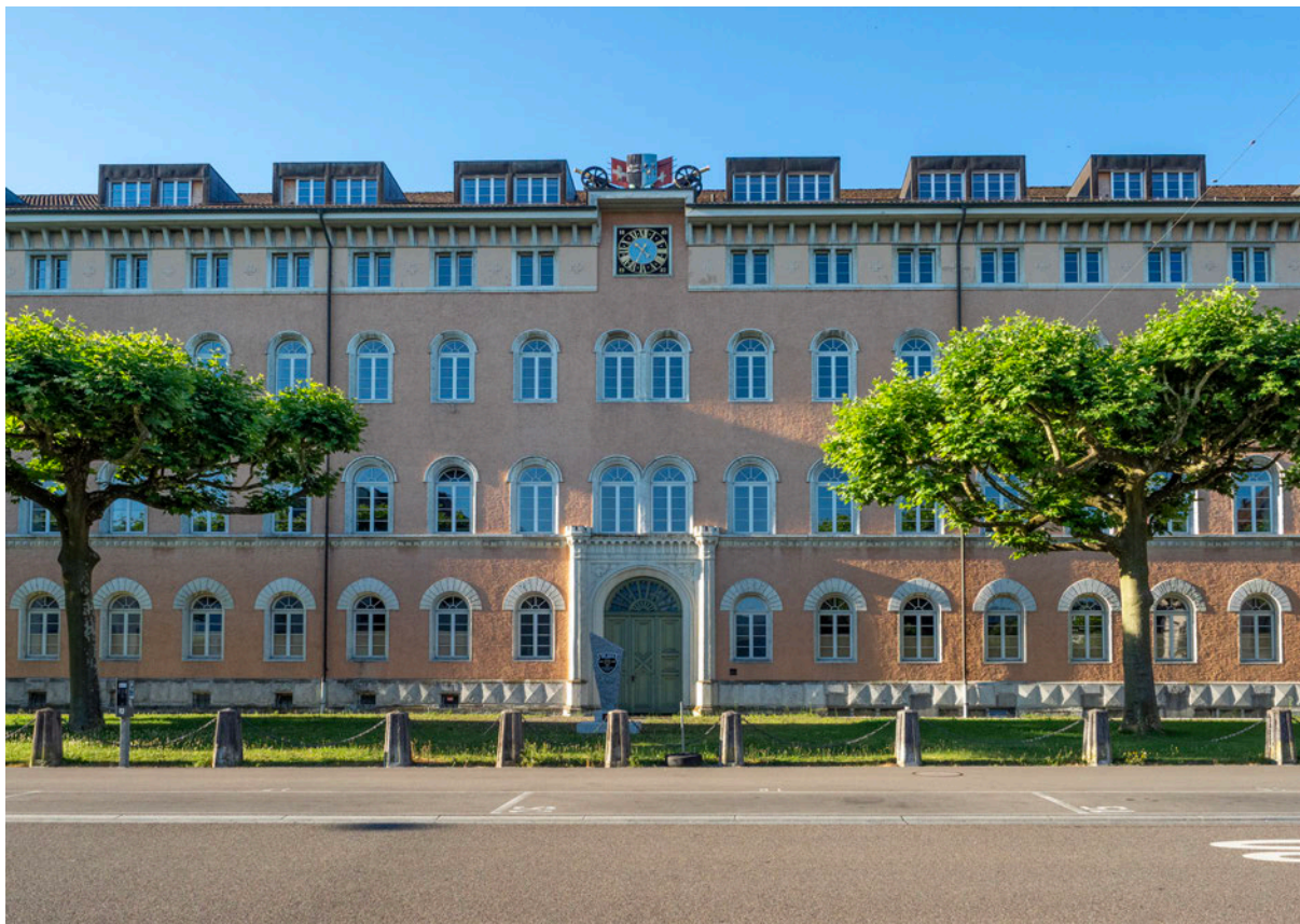
Die Kaserne an der Laurenzenvorstadt prägt als historisches Gebäude das Aarauer Stadtbild.
