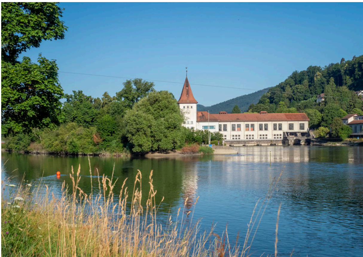
Bei der Vogelinsel und dem ehemaligen Eniwa-Kraftwerk vereinen sich die beiden Aarearme.
