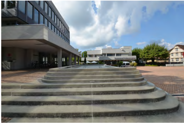
Platzanlage Obere Vorstadt 36, 01.10.2014.
