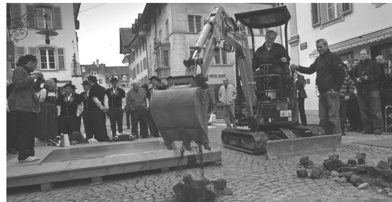
Stadtmann Dr. Marcel Guignard führt den Spatenstich zur Neugestaltung der Altstadtgassen aus.
