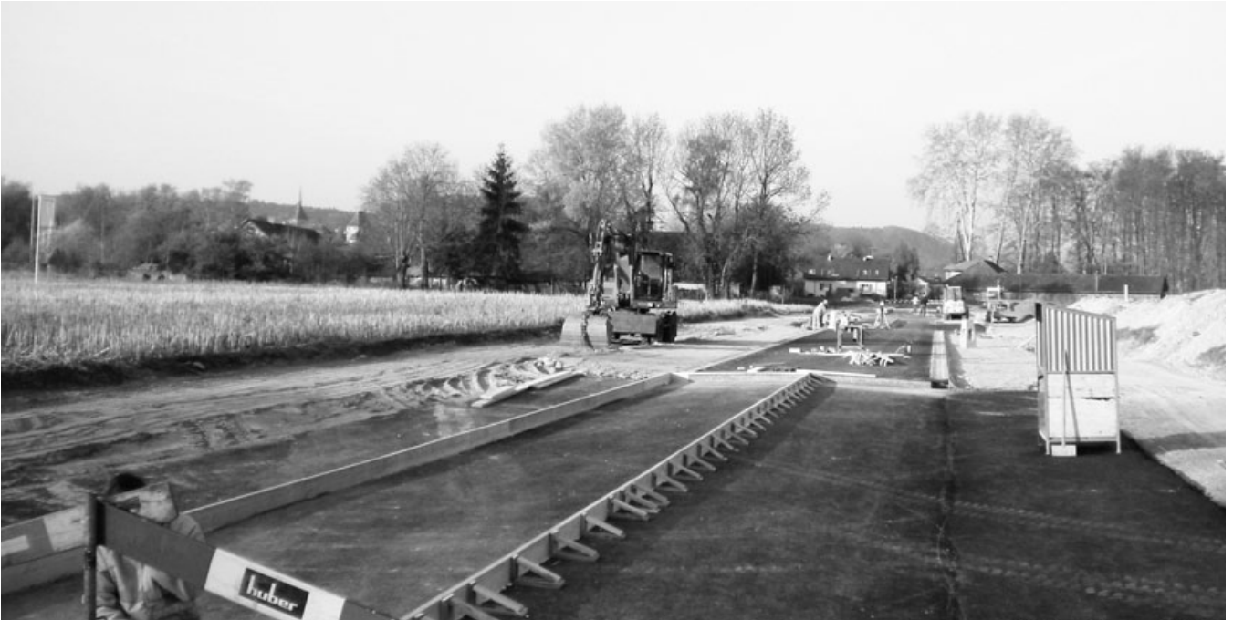
Die Erschliessung Scheibenschachen kurz vor der Vollendung.
