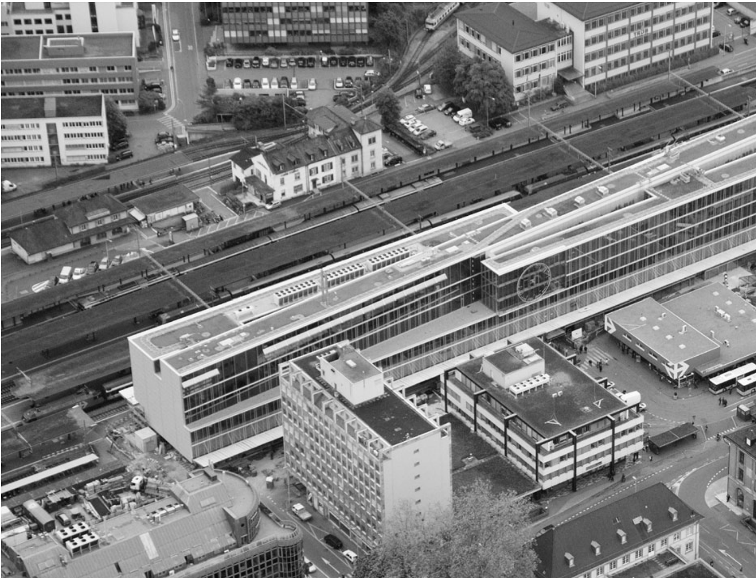
Die Vorbereitungsarbeiten für das Projekt «Neugestaltung Bahnhofplatz und Bushof» sind bereits im Gange. Der Baubeginn ist auf nächsten Frühling geplant.
