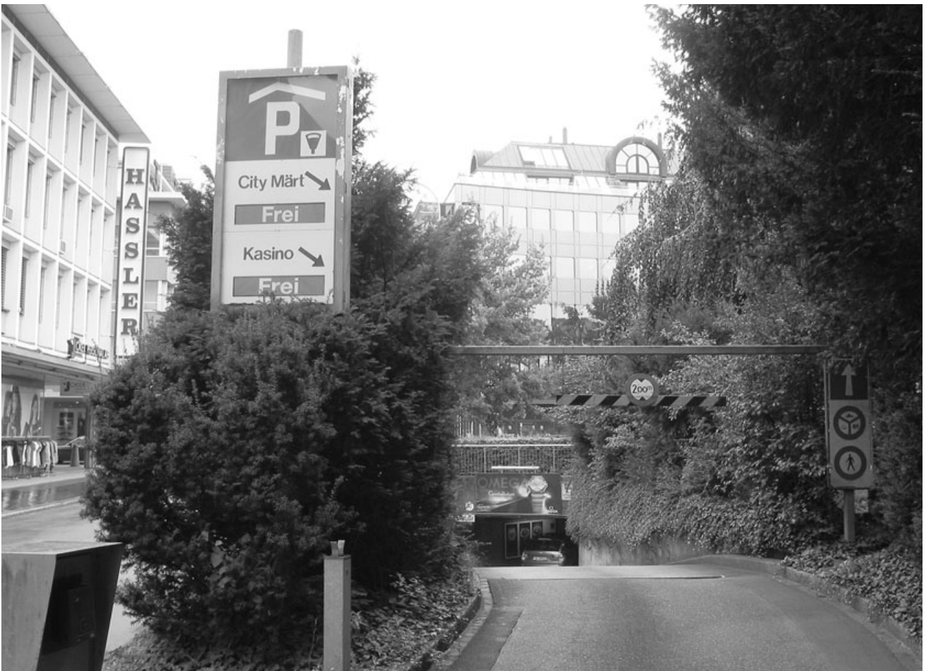
Im Jahr 2011 steht die Sanierung des Parkhauses Kasinopark an.
