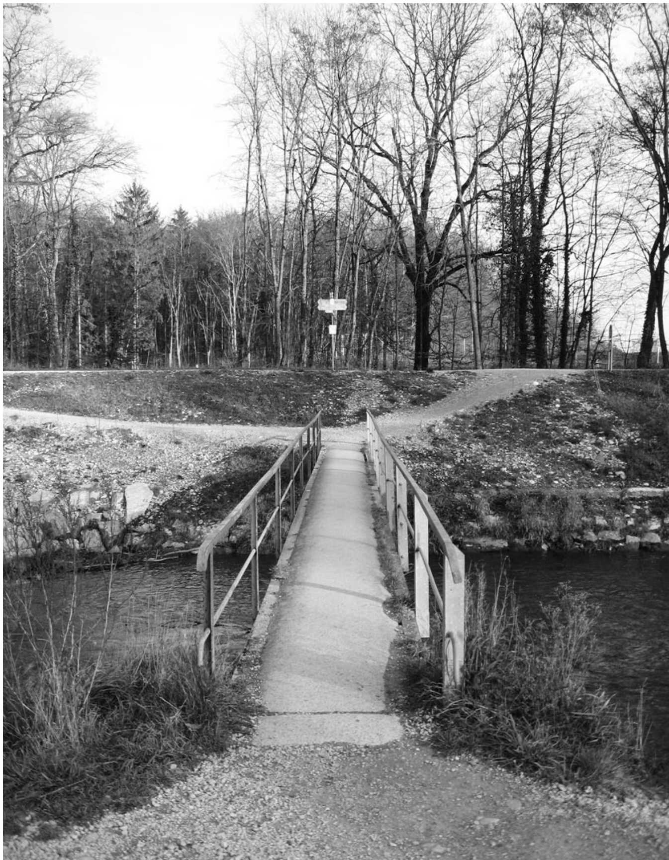
Für die Erneuerung und den Unterhalt des Suhrensteigs ist die Stadt Aarau zuständig.
