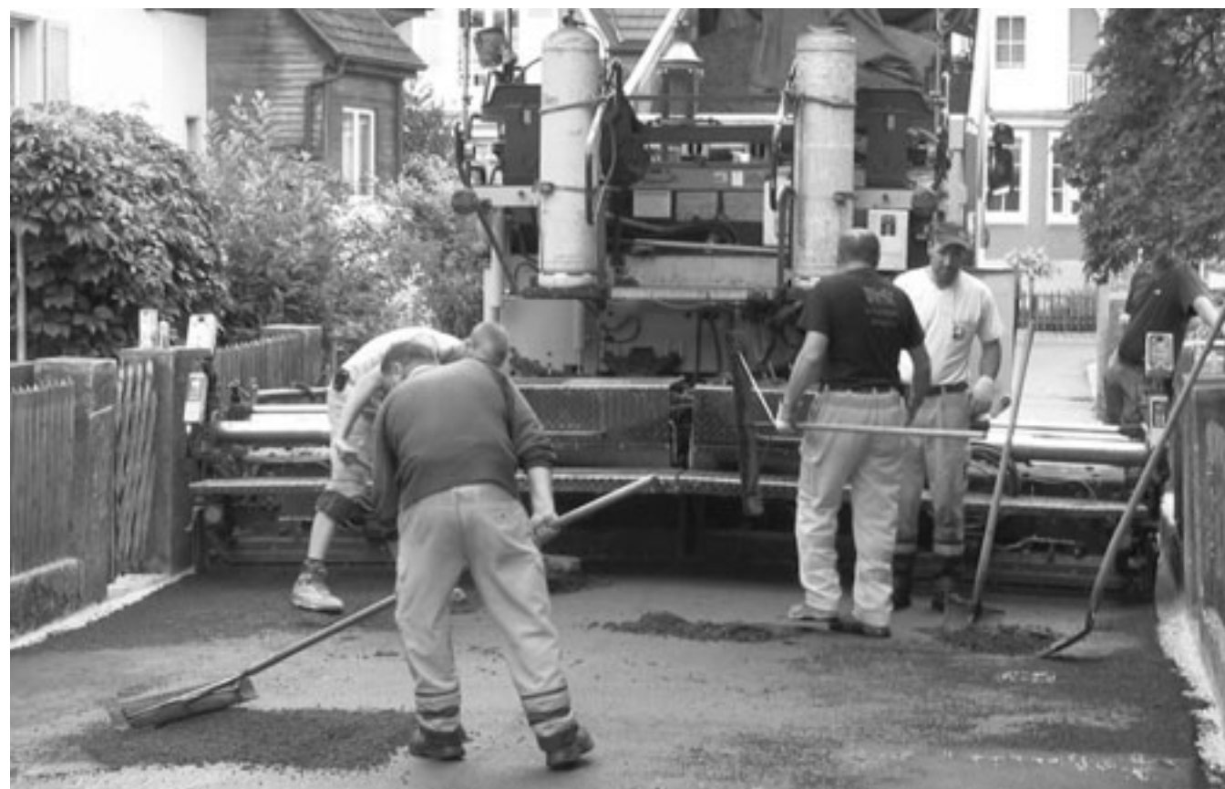
Sanierungsarbeiten am Ahornweg.
