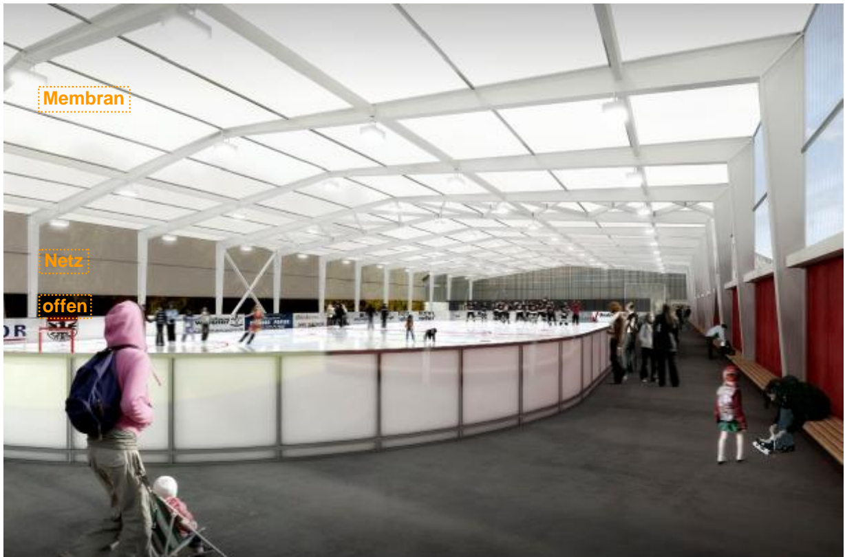
Bild 3 Das neue Ausseneisfeld wird durch eine transluzente Folie vor Sonne und Regen geschützt
