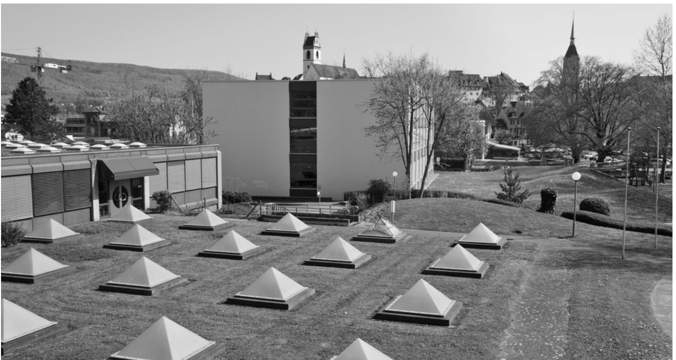
In den Jahren 2012/2013 wird das Oberstufenschulhaus Schachen einer Analyse in Bezug auf energetische Mängel unterzogen.
