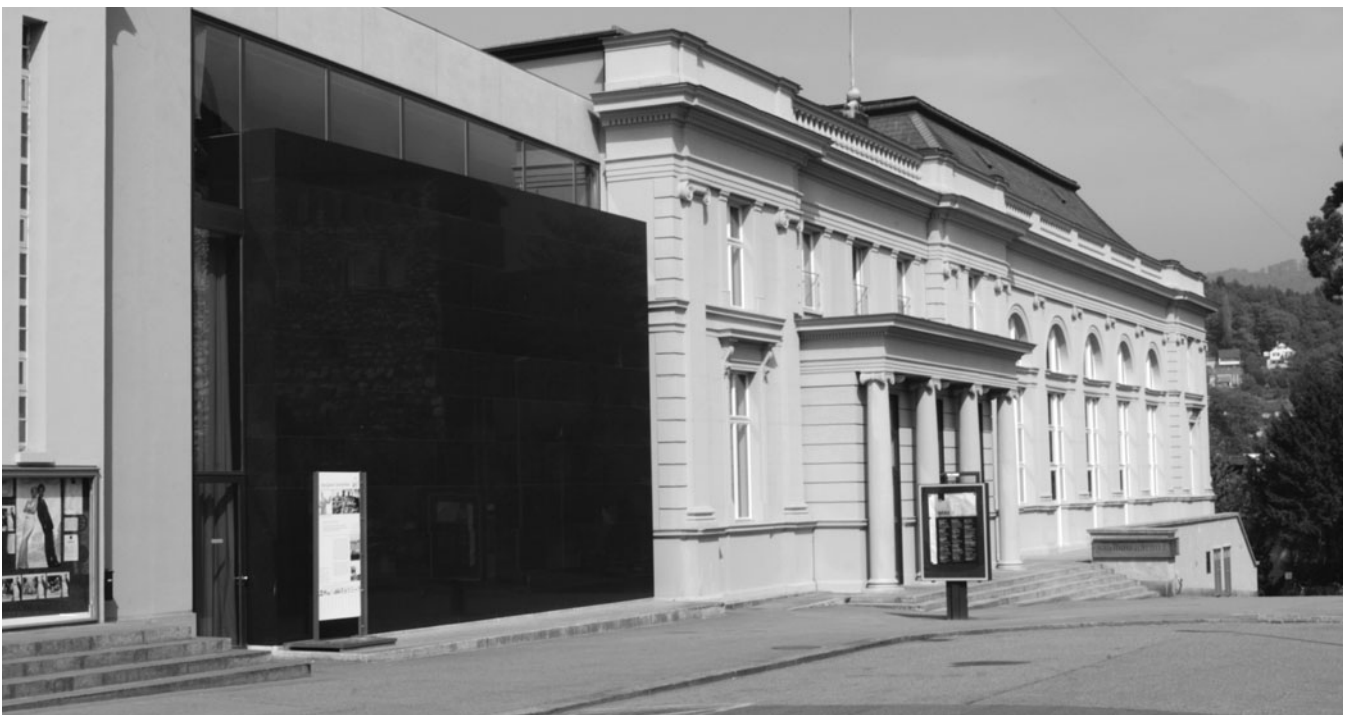
Das KUK erhält eine neue Heizung.
