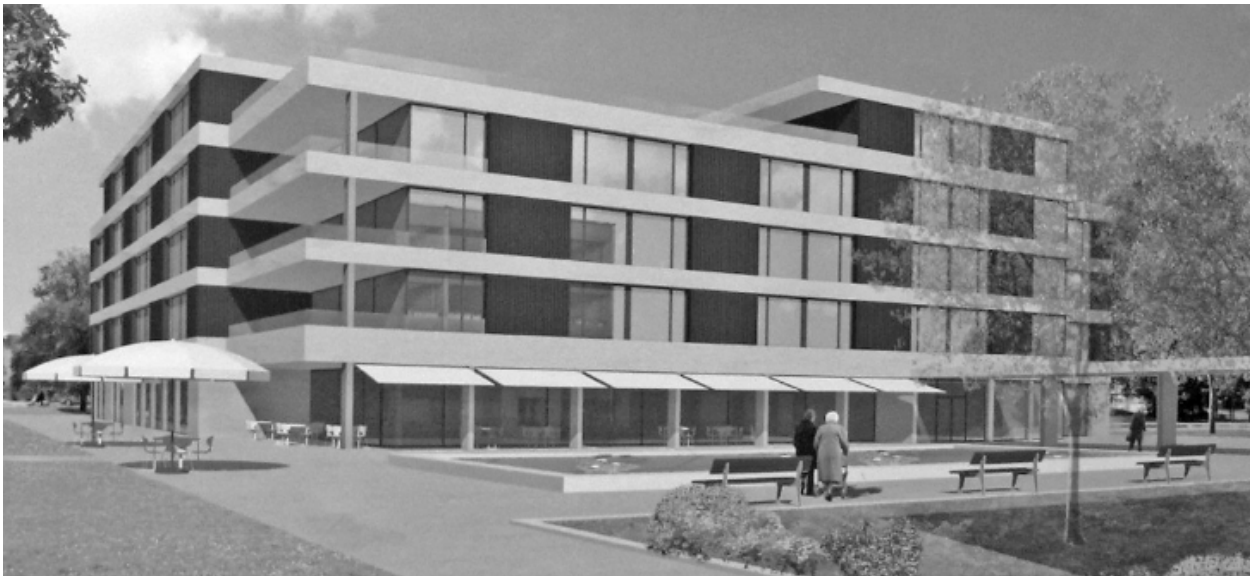
Ostansicht Alterszentrum Suhrhard
