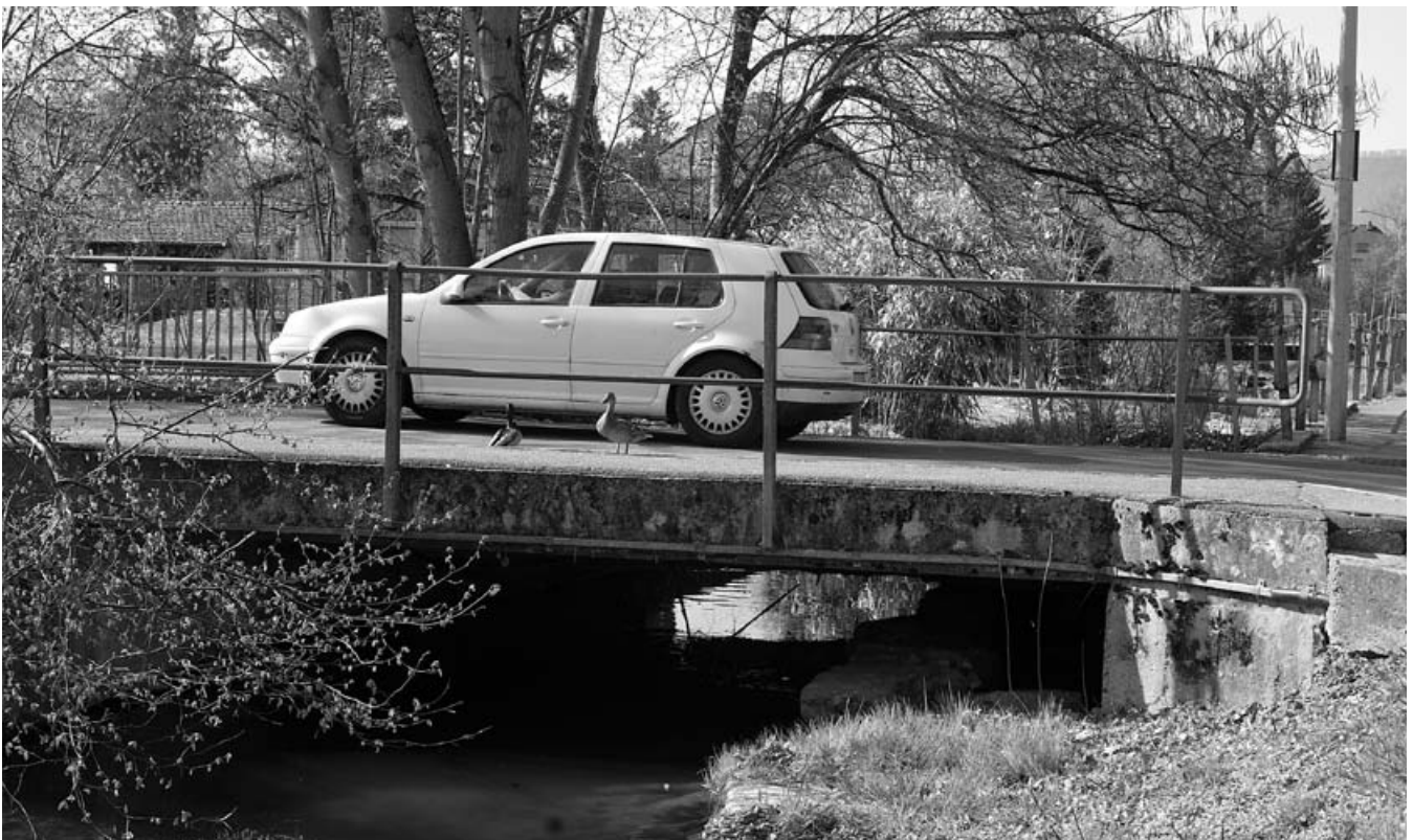
Verschiedene Brücken über den Stadtbach werden saniert.
