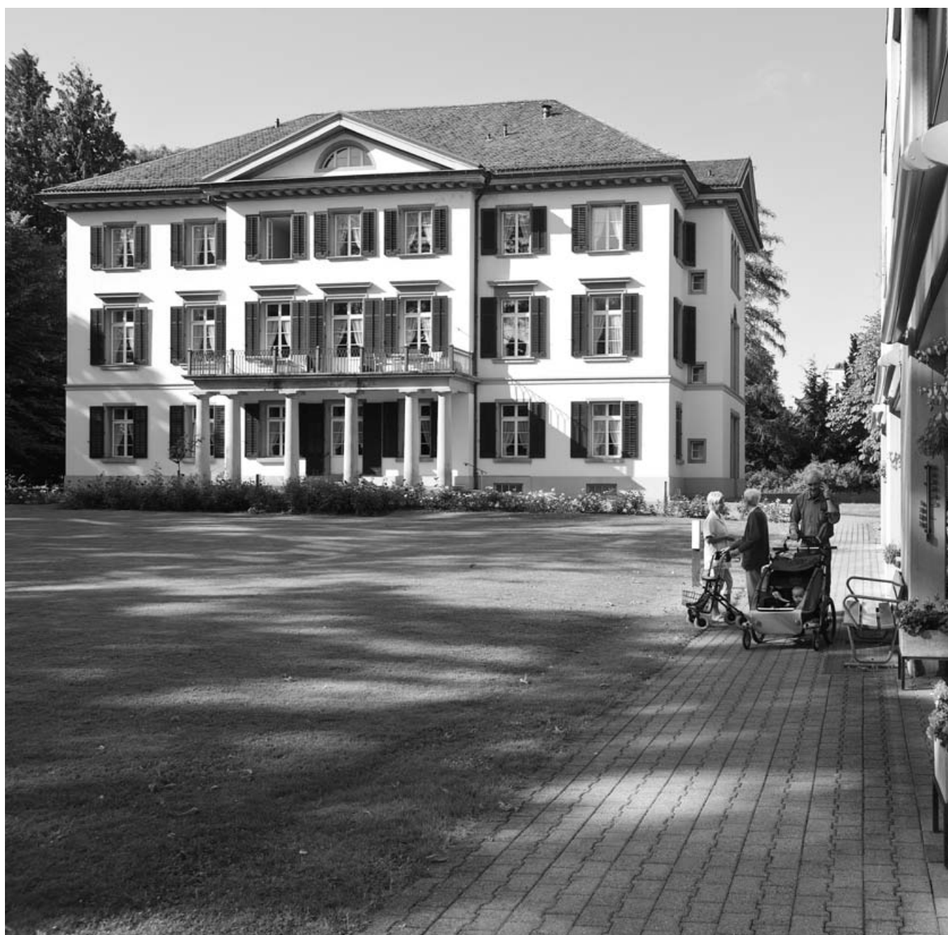
Im Rahmen der Gesamtsanierung des Hauptgebäudes des Pflegeheims Herosé muss auch die Zukunft des Herzoghauses geklärt werden.
