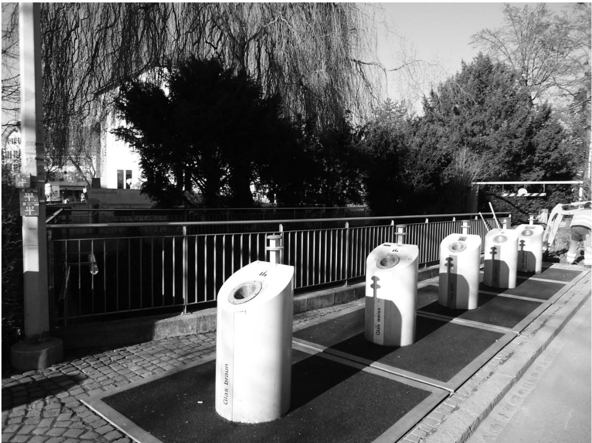
Die Sammelstellen des Aarauer Werkhofs fördern das umweltbewusste Abfallentsorgen.
