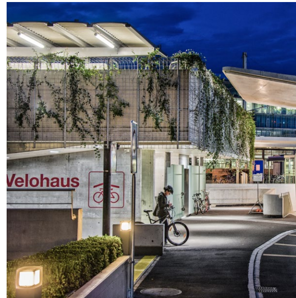
Die Velostation Süd bietet moderne und komfortable Veloabstellplätze in unmittelbarer Gleisnähe.
