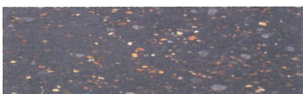
Bituminöser Belag mit Einstreuung von farbigen Natursteinkörnern
