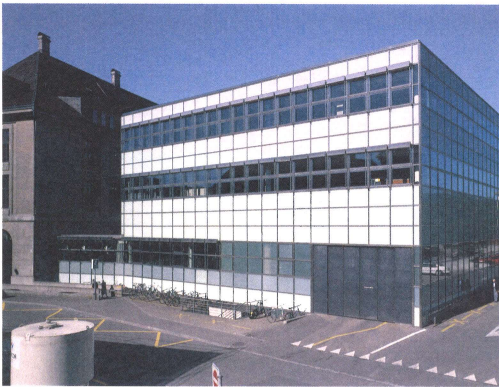
Ansicht Rückseite Hauptpost
