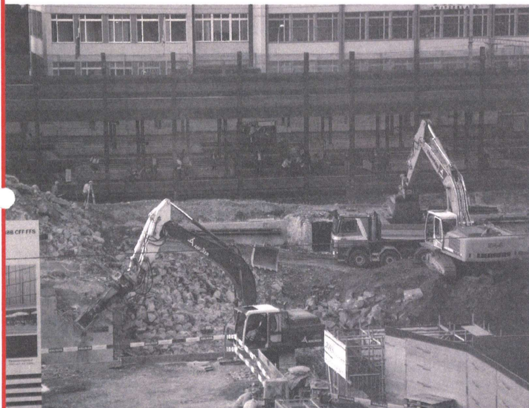
Mitten im Umbruch: Rück- und Neubau Bahnhof Aarau
