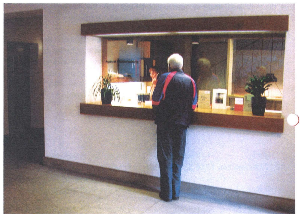
Zustand heute: Der Empfang am Haupteingang und die Telefonzentrale sind weder zeitgemäss noch einladend.
