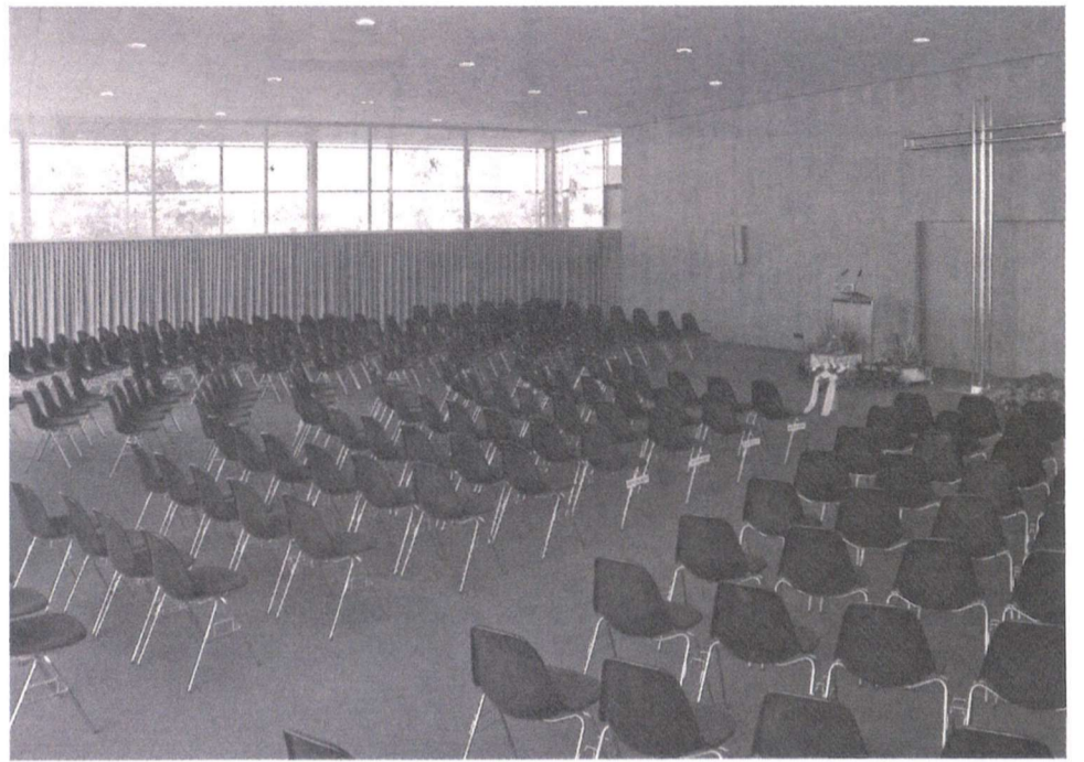
Auch der Innenraum bedarf einer dringenden Erneuerung
