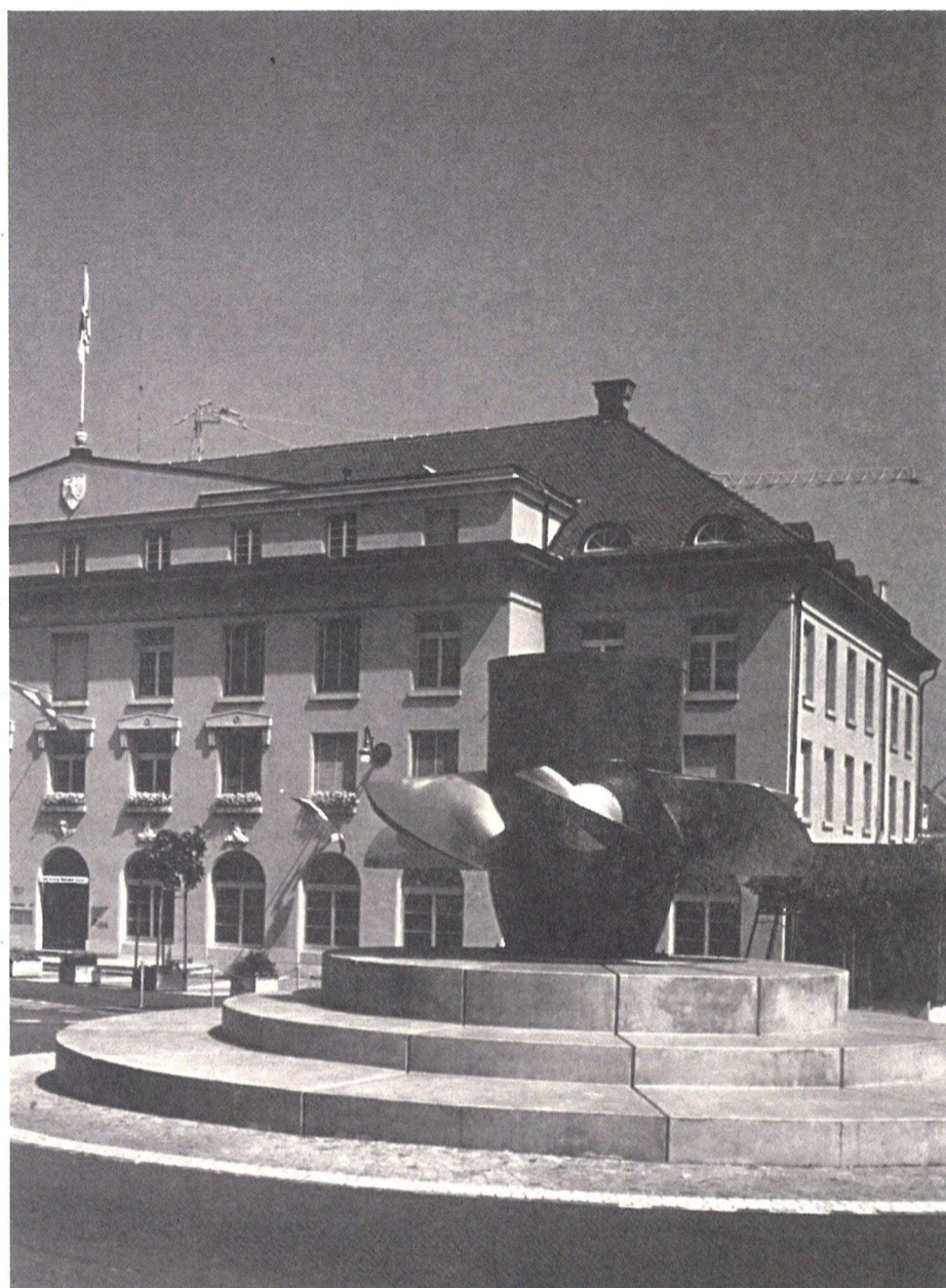
1996 werden die umfassenden Umbau- und Sanierungsarbeiten am und im Verwaltungsgebäude abgeschlossen.
